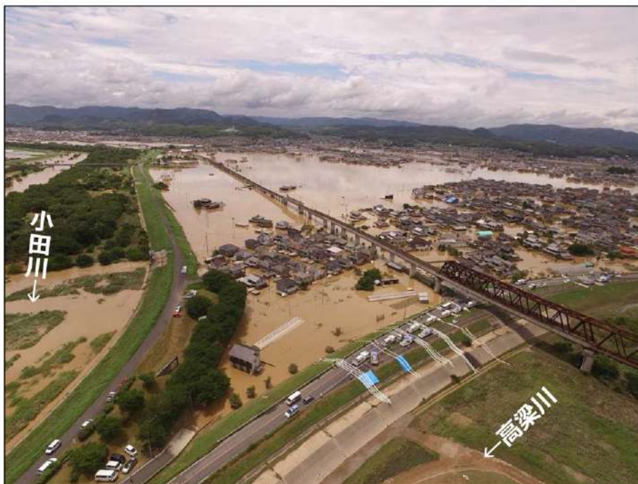
■岡山県倉敷市真備町の浸水状況
