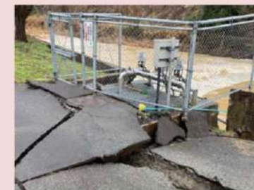
水道の復旧 (被災した浄水場)
